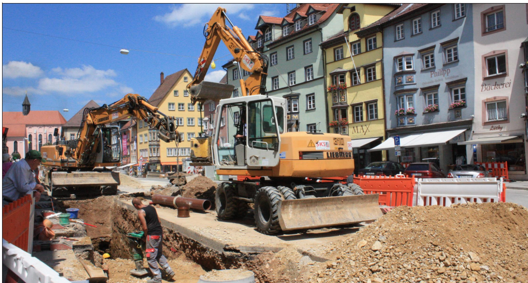
Volles Tempo für Rottweil-Mitte: Bauarbeiter verlegen in der Hochbrücktorstraße neue Rohre. Baurtrupps arbeiten parallel, um den ehrgeizigen Zeitplan einzuhalten. Foto: Hermann
